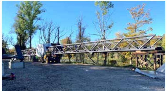
Der Bau der Radwegebrücke über die Isar kommt gut voran: Die Betonbauarbeiten sind zwischenzeitlich abgeschlossen. Die Stahlbaufertigteile wurden zum großen Teil angeliefert und sollen noch in diesem Jahr eingehoben werden.
