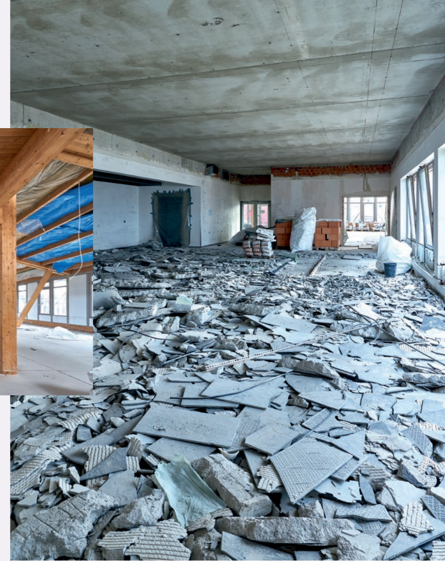
ABBRUCH DES BODENAUFBAUS IN DER ZUKÜNFTIGEN MENSA
