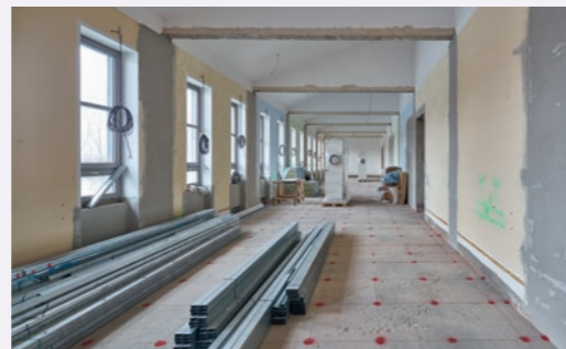
KLASSENZIMMER VOR DEM INNENAUSBAU
