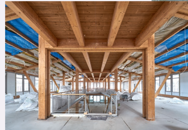
VERWALTUNGSBAU OG / RÜCKBAU ALLER INNENWÄNDE, KOMPLETTE SANIERUNG DER DACHFLÄCHEN AUSSEN WIE INNEN; HIER SIND LEHRERBEREICHE UND VERWALTUNG UNTERGEBRACHT
