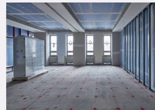
KLASSENZIMMER / DIE DECKE IST MIT EINER AKUSTIK- DÄMMUNG UND GIPSKARTONPLATTEN BEREITS SCHALLSCHUTZTECHNISCH ERTÜCHTIGT; MAN ERKENNT DIE GROSSEN STAHLBETONUNTERZÜGE, DIE DIE DECKEN TRAGEN. NEUE STAHLSTÜTZEN VERBESSERN DIE TRAGKONSTRUKTION
